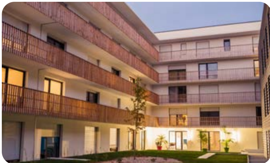
Résidence Logifac La Rivière - Nantes
